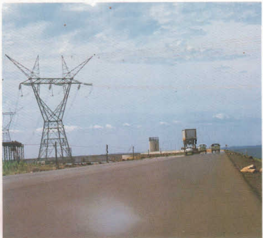
Pavimentación del coronamiento de la presa.
