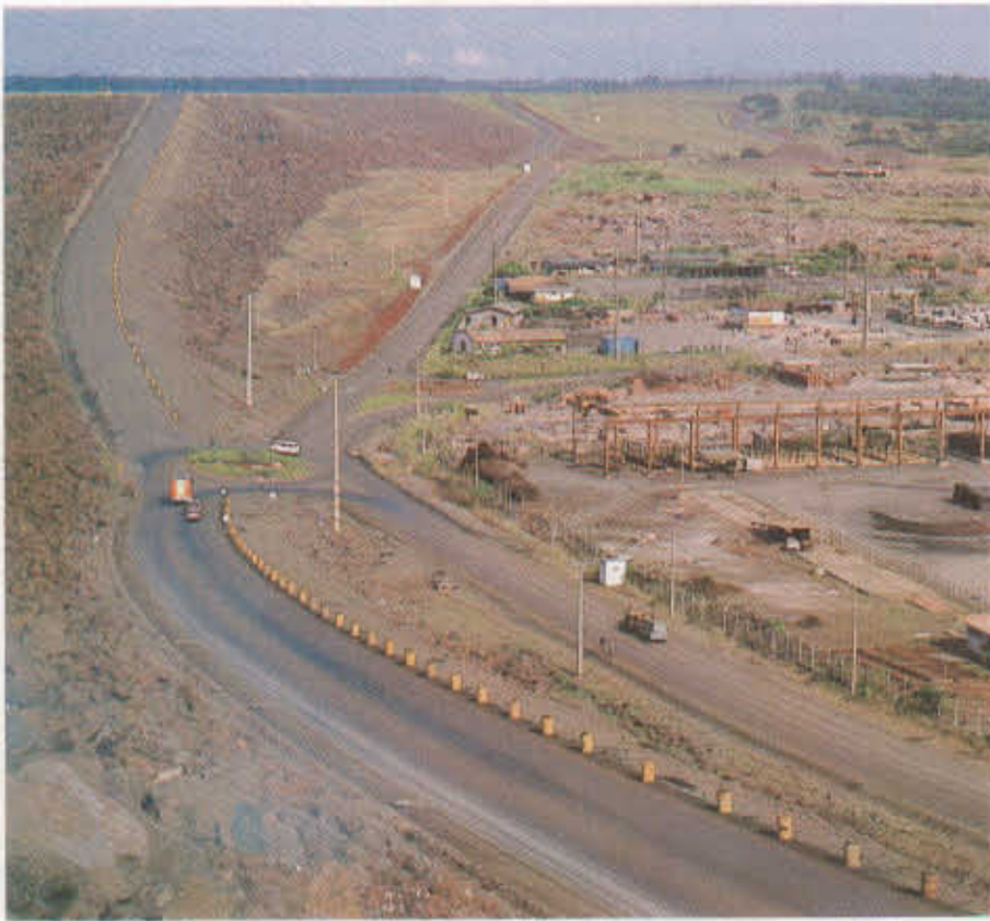
Pavimentación del sistema vial.
