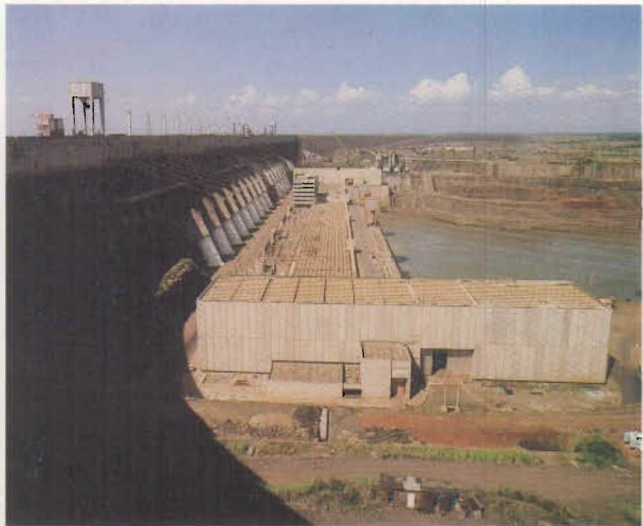
Trecho de la casa de máquinas en el lecho del río - Concluido. Vista lateral.
