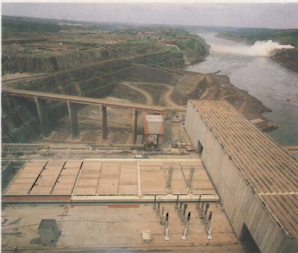
Atagüa del canal de desvío, a ser demolida en el transcurso de 1989.
