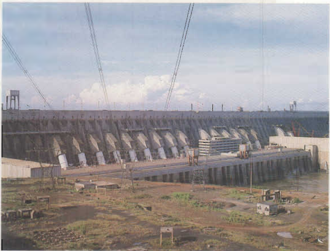
Trecho de la casa de máquinas en el lecho del río - Concluido. Vista de aguas abajo.
