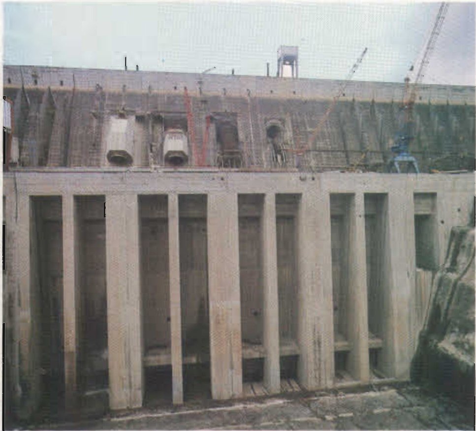
Trecho de la casa de máquinas en el canal de desvío Vista de aguas abajo
