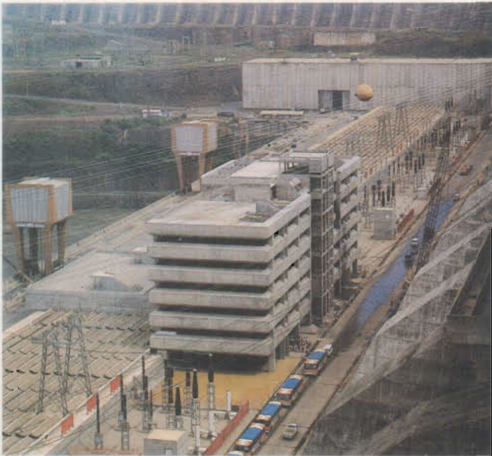
Edificio de operación.
